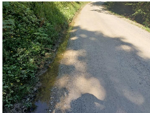
Sliki 9 in 10: Zastajanje vode ob levem robu vozišča od 3.890 do km 4.220
