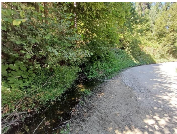
Sliki 9 in 10: Zastajanje vode ob levem robu vozišča od 3.890 do km 4.220
